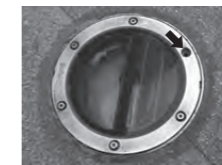
ボルトの欠落
